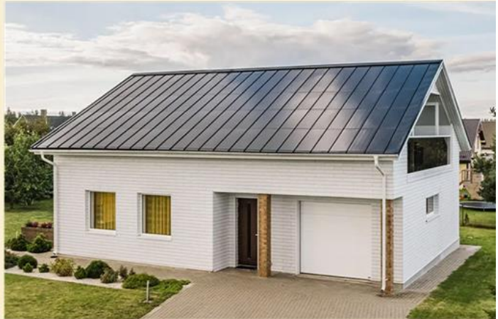
Сонячна покрівля Roofit.Solar у вигляді фальцевих профілів
