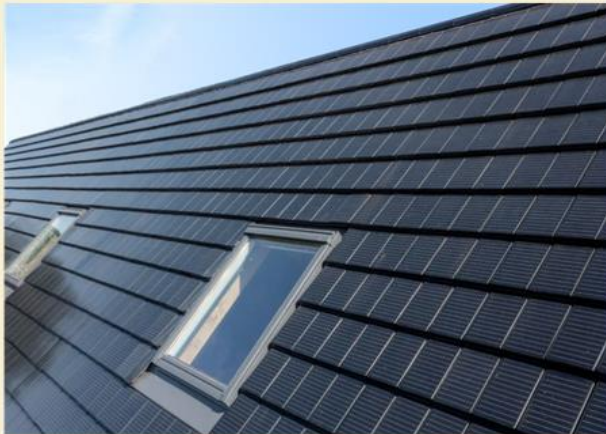
Сонячна покрівля Roofit.Solar у вигляді фальцевих профілів
