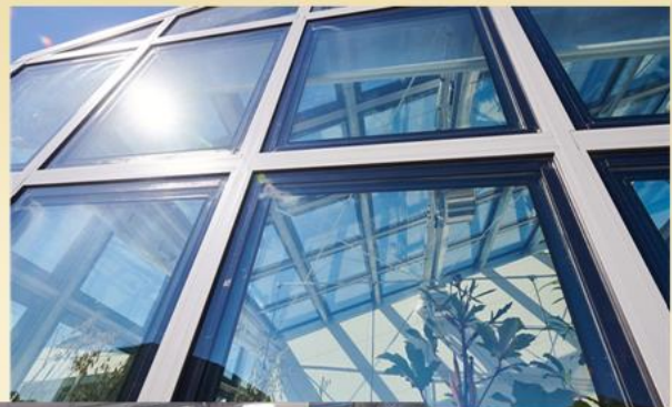
Сонячне вікно ClearVue PV з технологією перенаправлення енергії до країв скла
