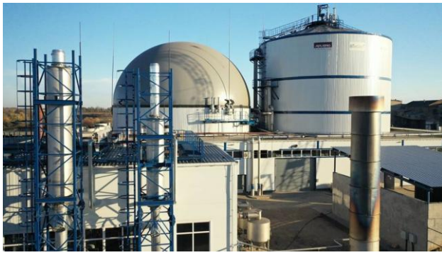
Біогазова електростанція, Вінницька область
